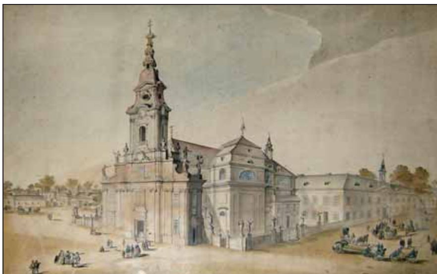
Fig. 2. Perspectiva aeriană a bisericii (Arhiva Parohiei Romano-Catolice, Carei. Fotografia autorului)
