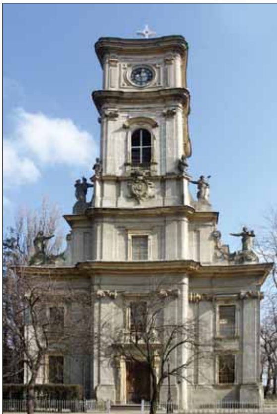
Fig. 1. Fațada principală a bisericii piariste Sfântul Iosif de Calasanz din Carei
