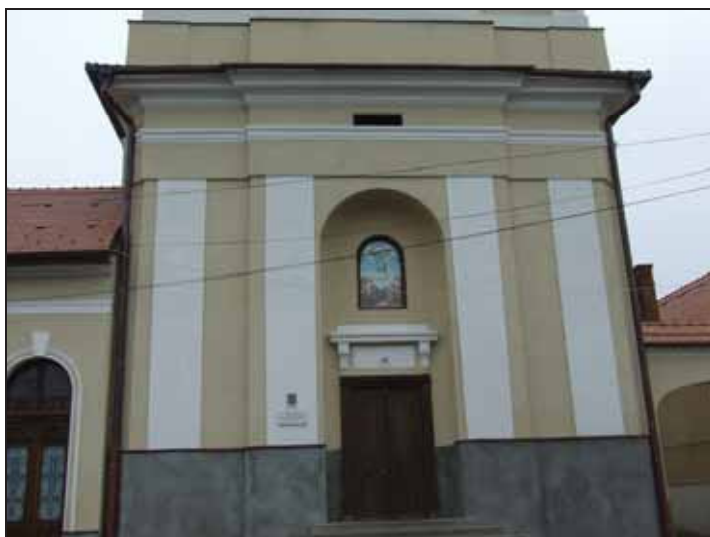
Biserica greco-catolică, Mediaș (detaliu fațada de vest)
