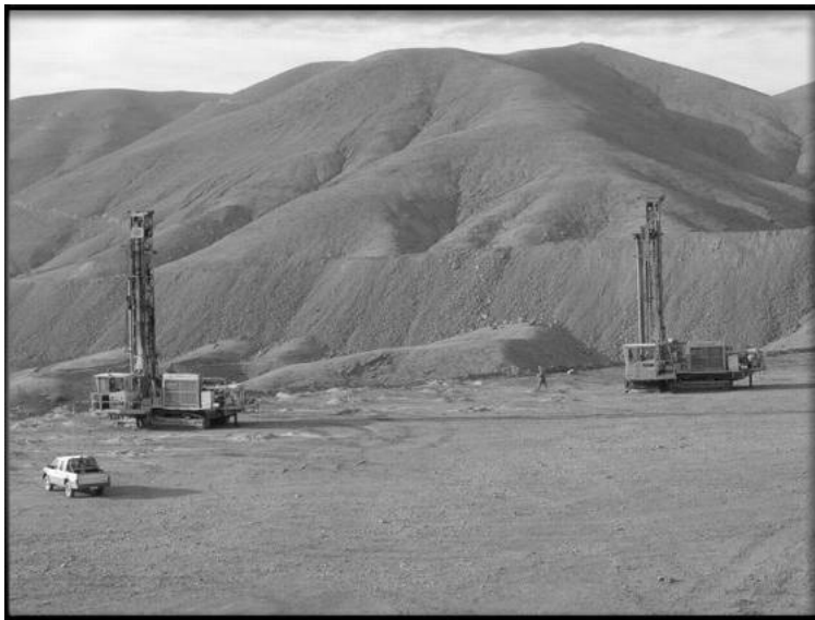
Fig. 5. Equipos de perforación
