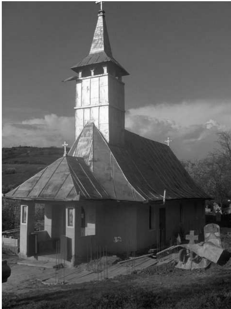
1. Biserica din Țaga înainte de demolare
